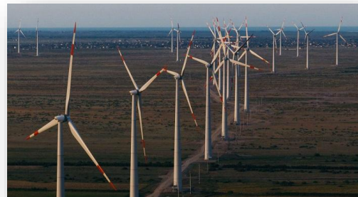
«Росатом» ввел в эксплуатацию Новолакскую ветроэлектростанцию (Республика Дагестан). Фото: atomic-energy.ru
