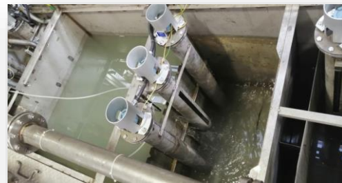
Устройство для улавливания нефти, нефтепродуктов и взвешенных веществ в производственно-дождевых сточных водах. Фото: НИИ «Транснефть»
