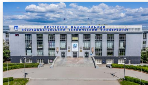
Главный корпус Иркутского национального исследовательского технического университета (ИРНИТУ). Фото: rostec.ru
