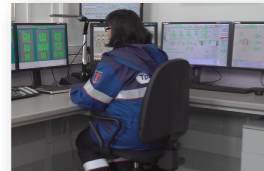
Автоматизированная система дистанционного контроля промышленной безопасности на опасных производственных объектах ООО «Транснефть – Балтика». Фото: «Транснефть»
