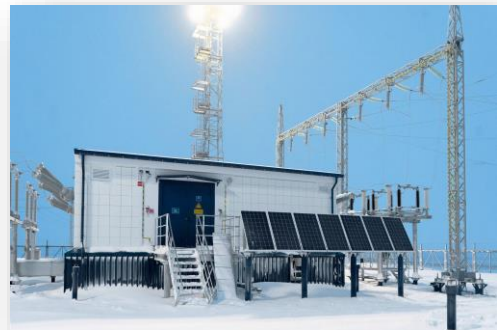
Цифровая подстанция «Север» Новопортовского месторождения. Фото: «Газпром нефть».
