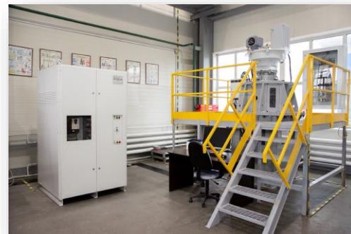
Испытательный стенд, предназначенный для проведения испытаний и настройки электроприводов.
