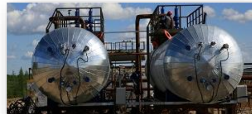
Мобильный комплекс подготовки нефти. Фото: Роснефть
